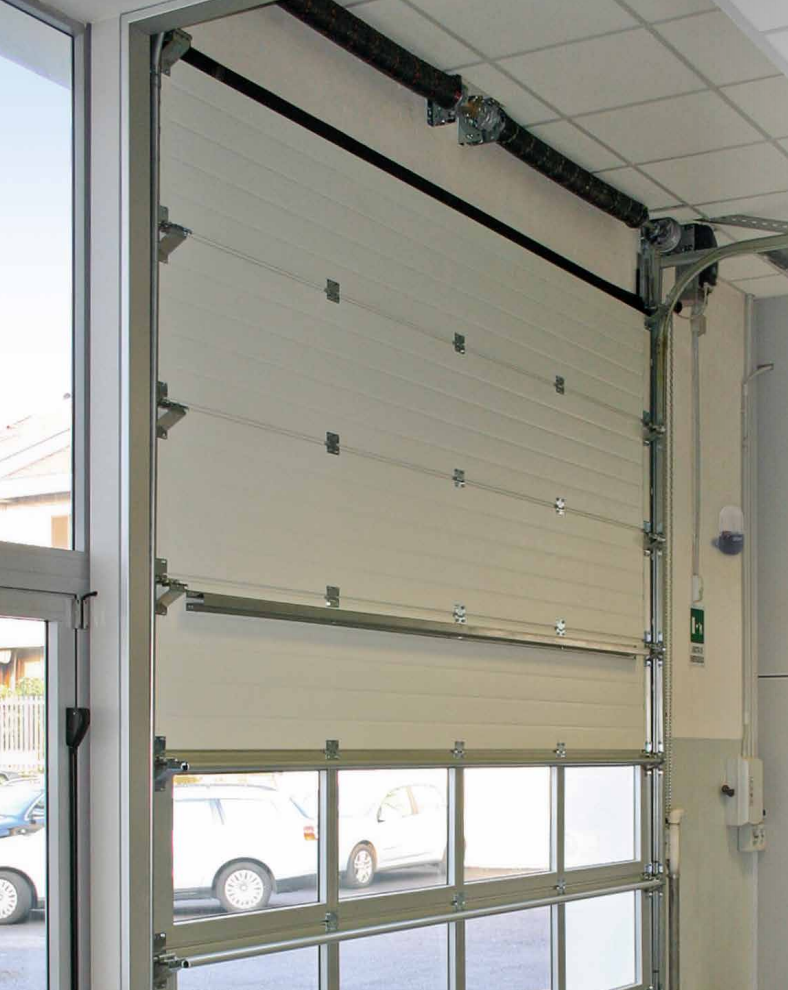
Porte sectionnelle avec renvoi à chaîne
